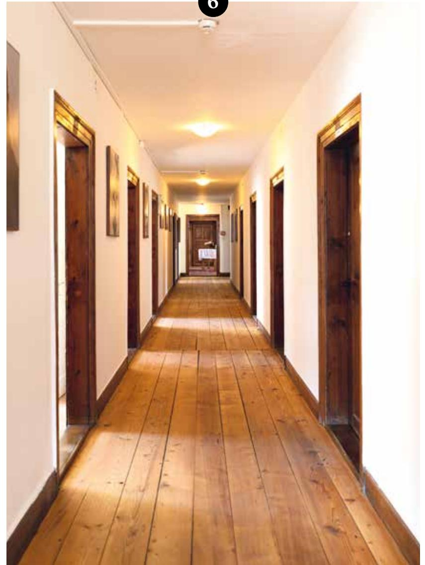
Die vorhandenen Rahmenpfosten wurden bei starker Beschädigung ergänzt bzw. teilweise erneuert. Teilweise waren einige Türen vorhanden, die im Stil nicht zu den ursprünglichen Ausführungen passten. Diese wurden durch neue Türen ersetzt. Die Ausführungen der neuen Türen wurden insgesamt an die vorhandenen angepasst, mit Täfer in der Gliederung strukturiert und mit dezenter Farbgebung an den Bestand angepasst.
