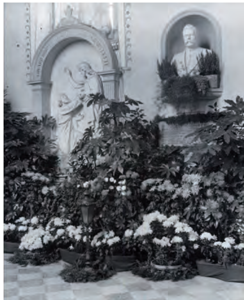
Die Grabstätte der Rhombergs in der Seitenkapelle vor der Renovierung 1962/63
