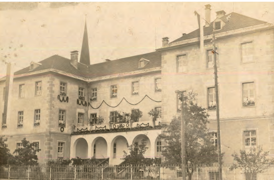
Das ehemalige Redemptoristenkolleg an der Haselstauderstraße
